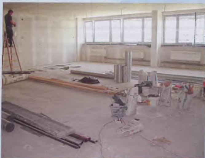
To będzie nowoczesna sala gimnastyczna w Szkole Życia, stan z maja br.
