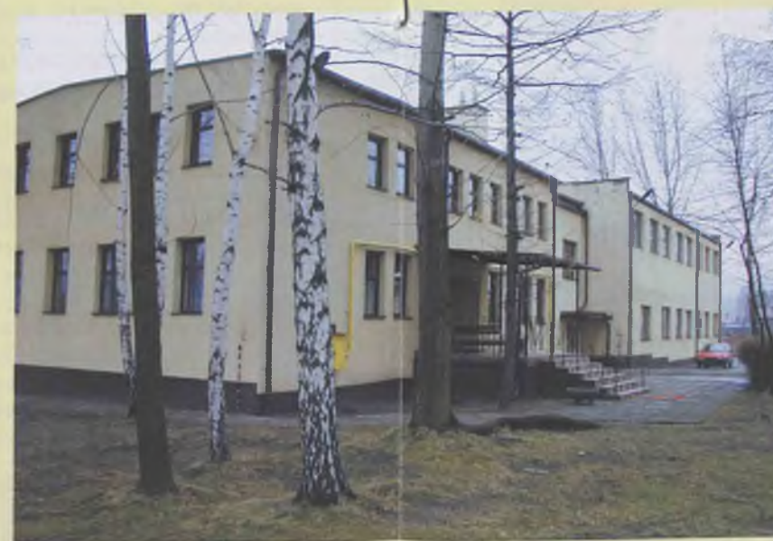
Odremontowany zakład w Dąbrowie Górniczej
