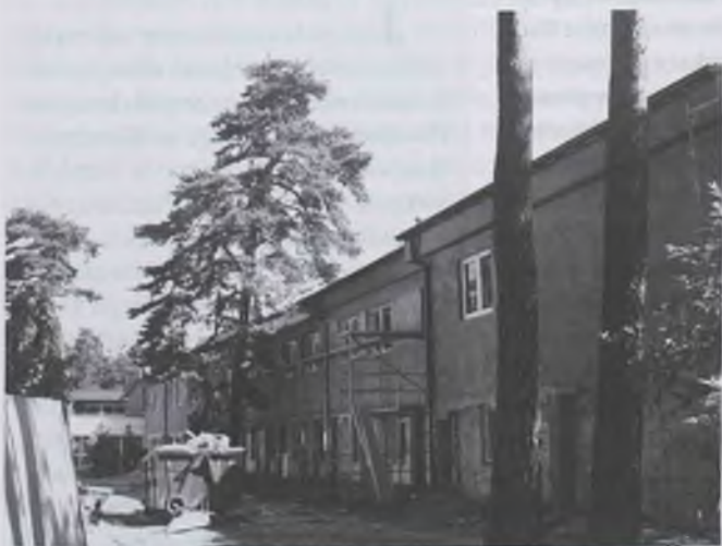
Budowa bloku operacyjnego, stan z sierpnia br.
