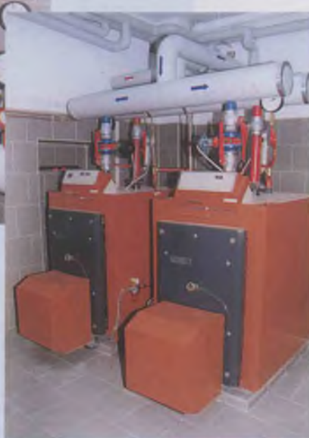
Nowa kotłownia olejowa
