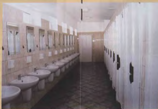
Część sanitarna po modernizacji
