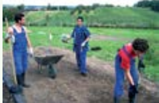
Stażyści z AIESEC budują ścieżkę „od podstaw”
