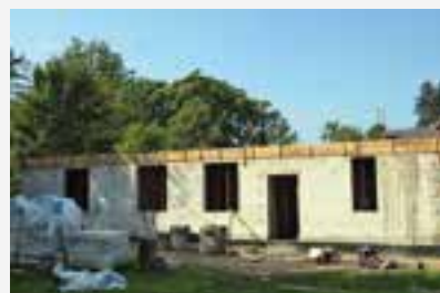
Budowa – widok z tyłu
